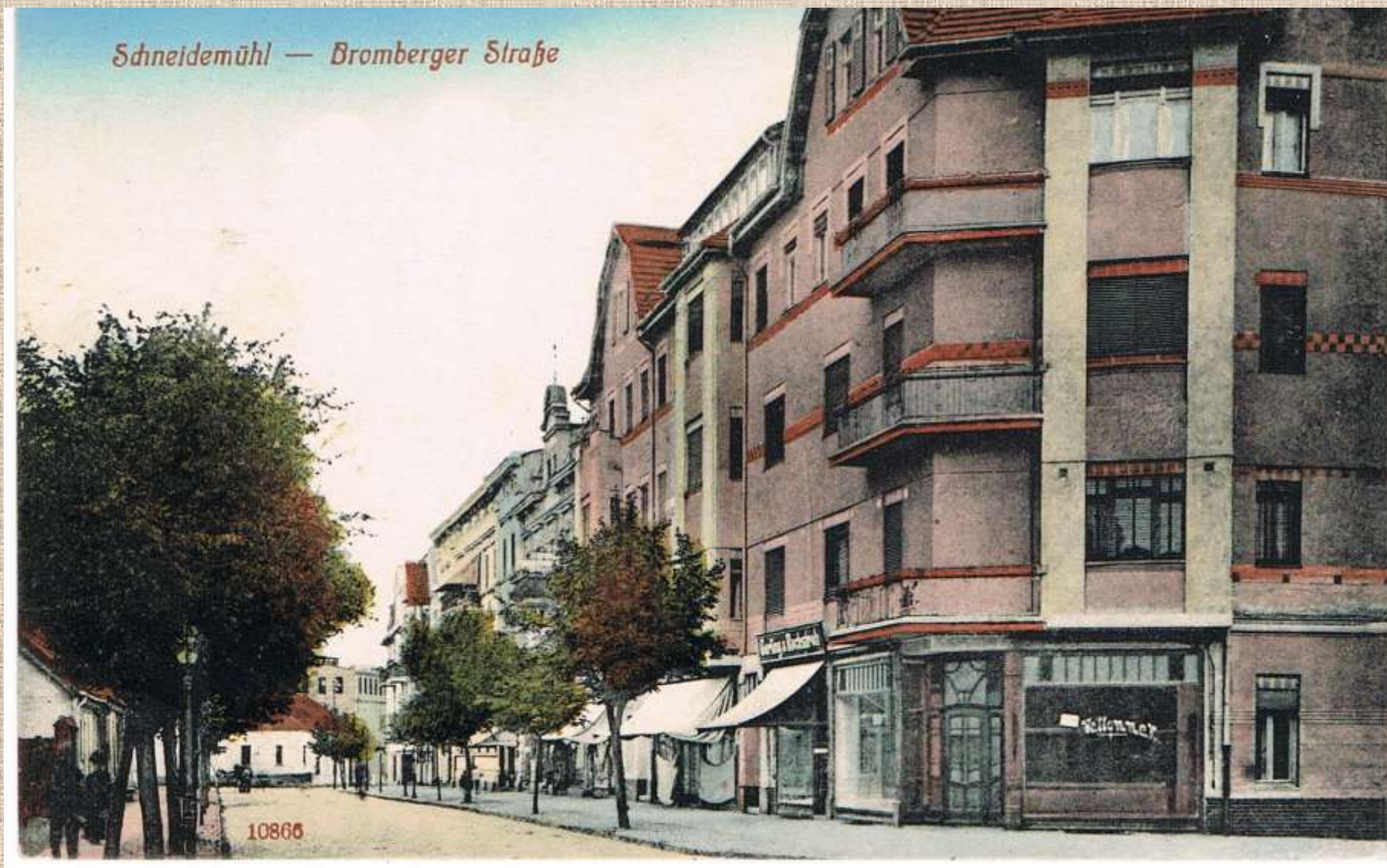
Ul. Bydgoska – widok z dawnego Placu Bydgoskiego w kierunku mostu – pocztówka.
